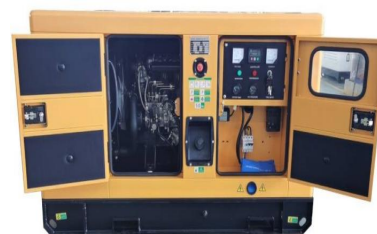
Vue cabine ouverte Accès maintenance
