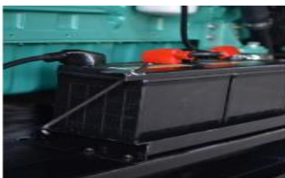
Batterie de démarrage 12 V / 60 Ah
