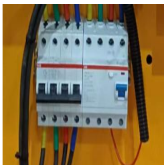
Disjoncteur ABB ABB S204-C32
