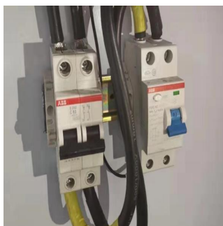
Disjoncteur ABB ABB S202-C80
